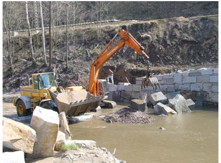
Bau der Steinschichtung
