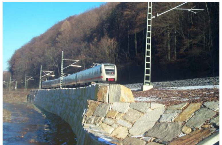
Fertige Steinschichtung S1 mit Bahnverkehr
