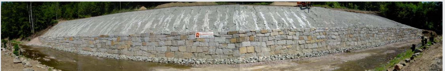
Steinschichtung Wand S2
