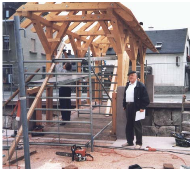
Drei Fußgängerstege aus Holz, davon einer gedeckt, verbinden die Straßen an den Ufern der Weißen Göltzsch. Die Tragwerke bestehen aus je zwei Leimbindern.
